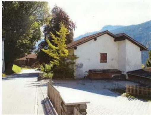
Ansicht von Nordwesten mit dem angebauten, gemauerten Abortturm. DPG 2013
